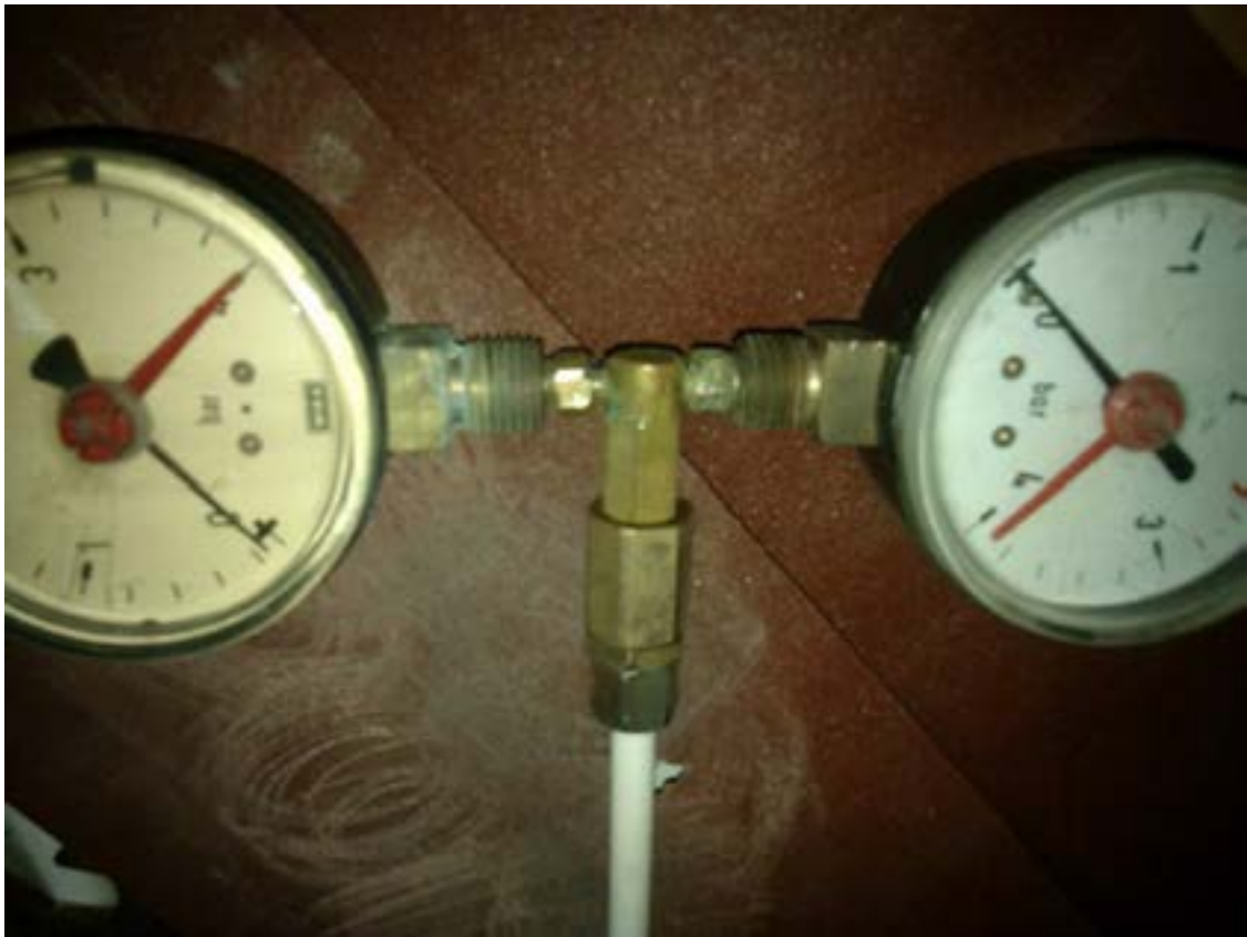
Particolare del giunto per i manometri
