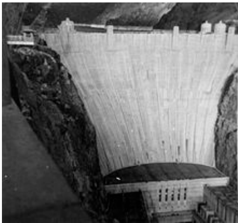
Diga ad arco utilizzata per produrre energia elettrica
