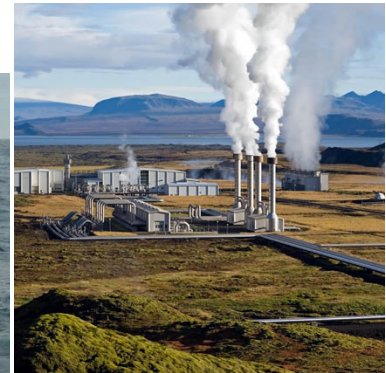
Impianto geotermico in Islanda
